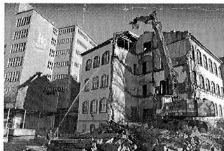
Der Abriss der ehemaligen Mädchenschule neben dem künftigen Landesarchäologiemuseum hat in dieser Woche begonnen. Bis Ende Dezember ist das denkmalgeschützte Haus, welches auch als Verwaltungs- und Lagergebäude für das benachbarte Kaufhaus genutzt wurde, verschwunden. A. Truxa
