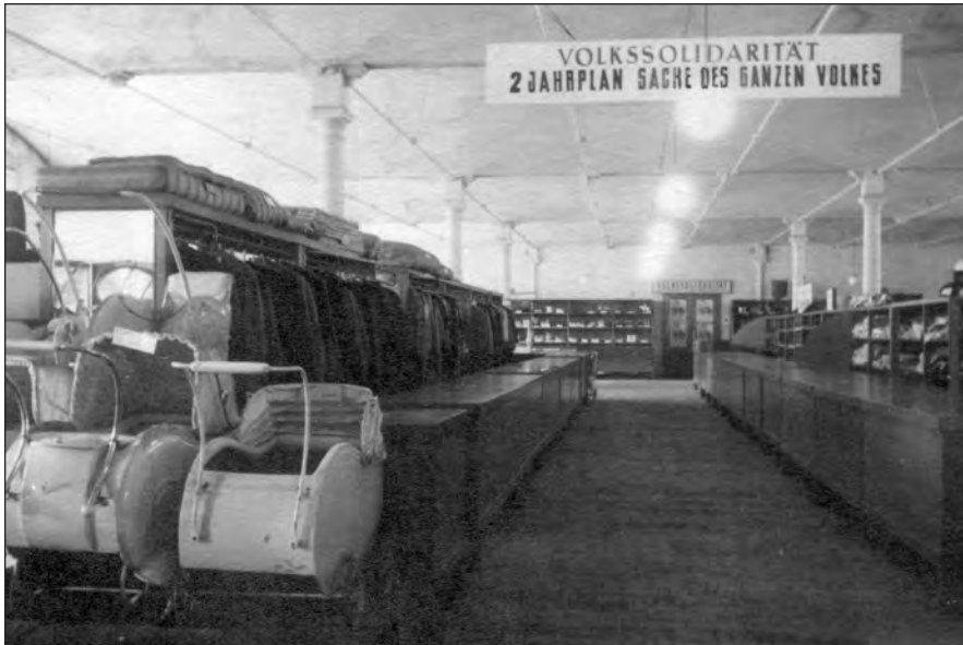
Blick in die Tauschzentrale im „Haus der Volkssolidarität“
